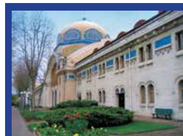
Термальный центр Centre des Domes в Виши
